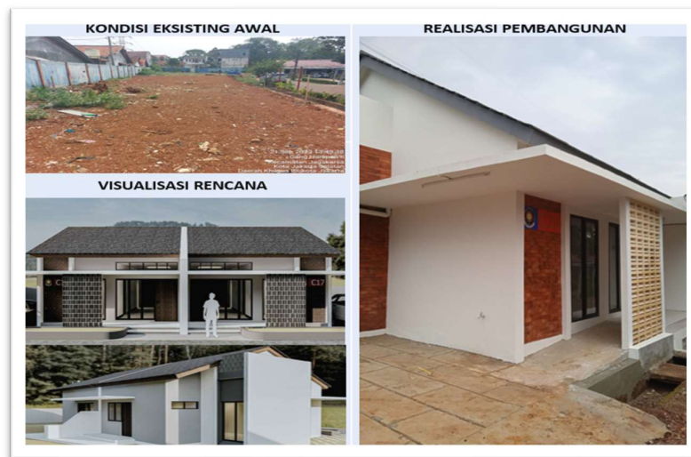
Gambar 3.13 Dokumentasi Pembangunan Rumah Dinas Penanggulangan Kebakaran dan Penyelamatan
