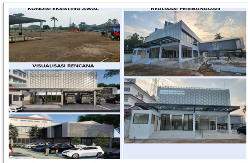
Gambar 3.15 Dokumentasi Pembangunan Gudang Barang Bukti Kejaksaan Negeri Jakarta Barat
